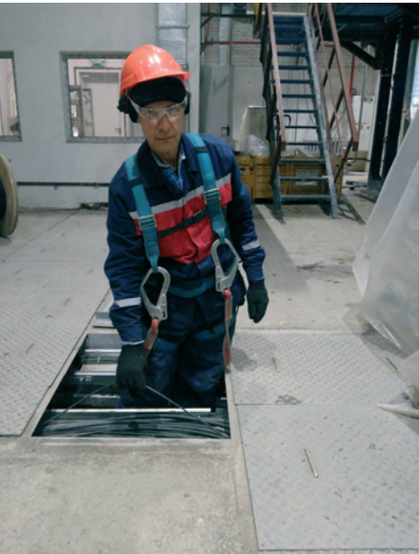
Крайнов СЕРГЕЙ, монтажник 4 разряда.
