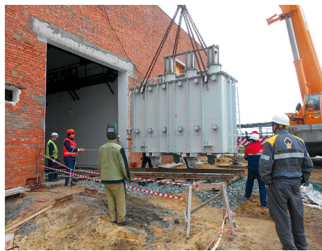
Установка трансформатора
